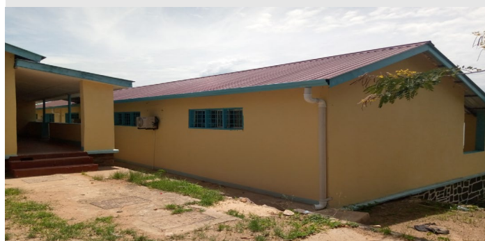
La toiture du LTRU en Zambie où seront installés les panneaux solaires
