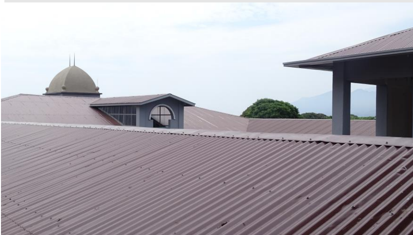
Toiture du CRH, future localisation des panneaux solaires
