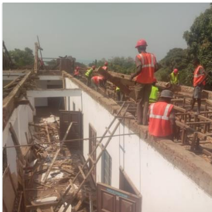
Vue du CRH en cours de réhabilitation
